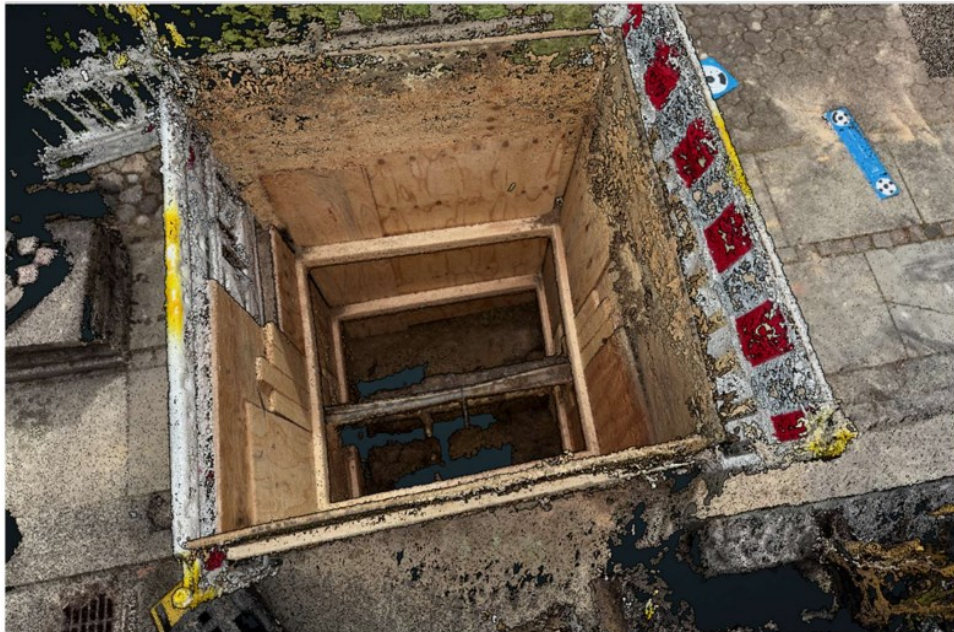
Figur 6. 3D-måling fra et tidligere HOFOR-vandledningsprojekt, der viser udformning af afstivning med træplader samt afspæringsmateriale (set ovenfra og ned i udgravningen).
